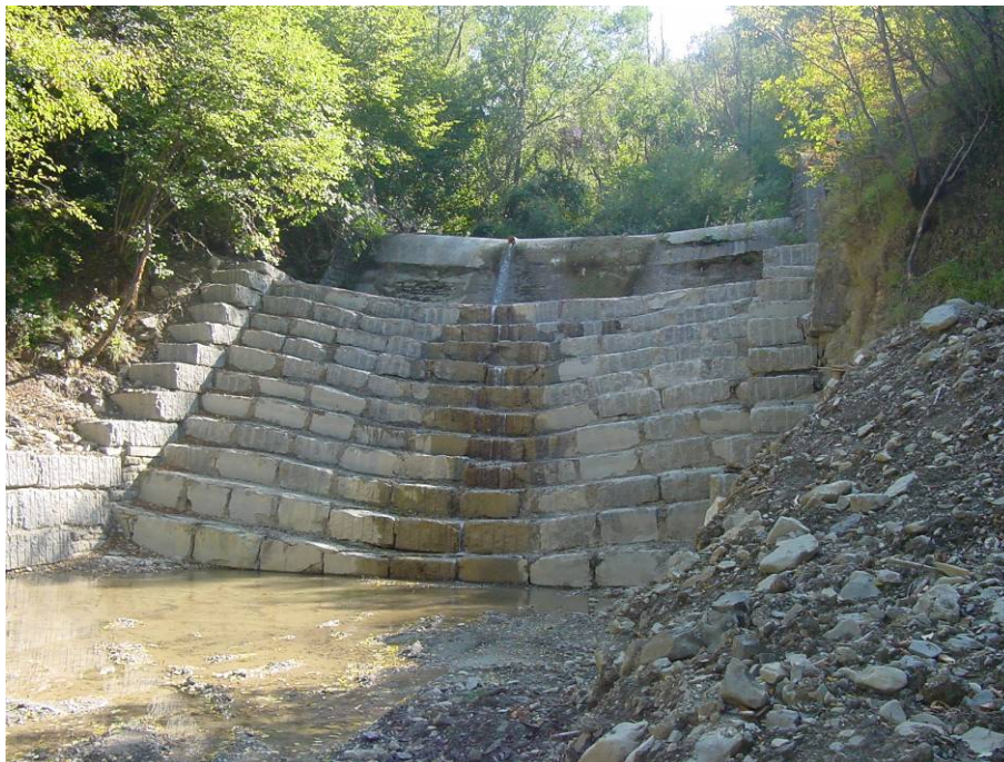
Realizzazione della briglia in blocchi di pietrame
